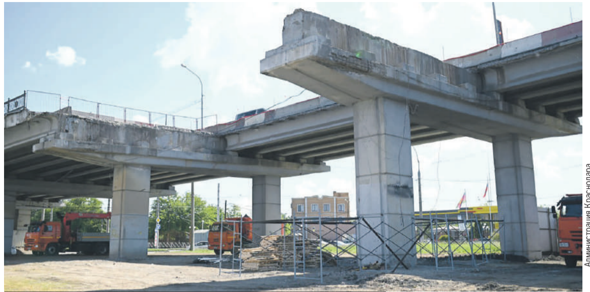
Одна из больших и важных строек крайцентра - ремонт Тургеневского моста.
