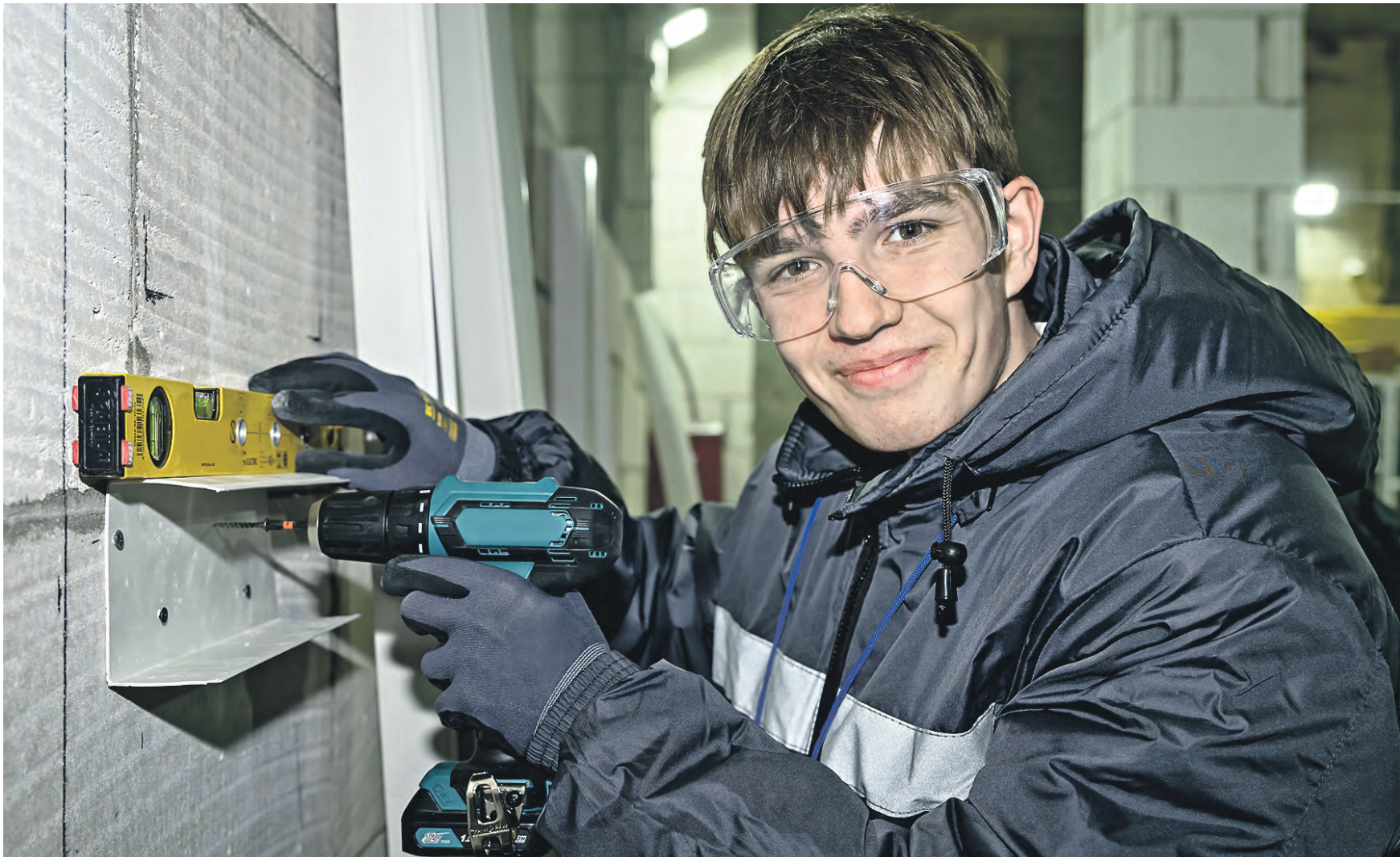
21 ноября. Ученик московской школы № 338 Степан Балашов с помощью шуруповерта и уровня монтирует кабель-канал в здании строящегося жилого дома. Возможность освоить профессию электромонтера старшеклассникам предоставили столичный колледж и крупный застройщик. Фото: Дмитрий Дубинский
