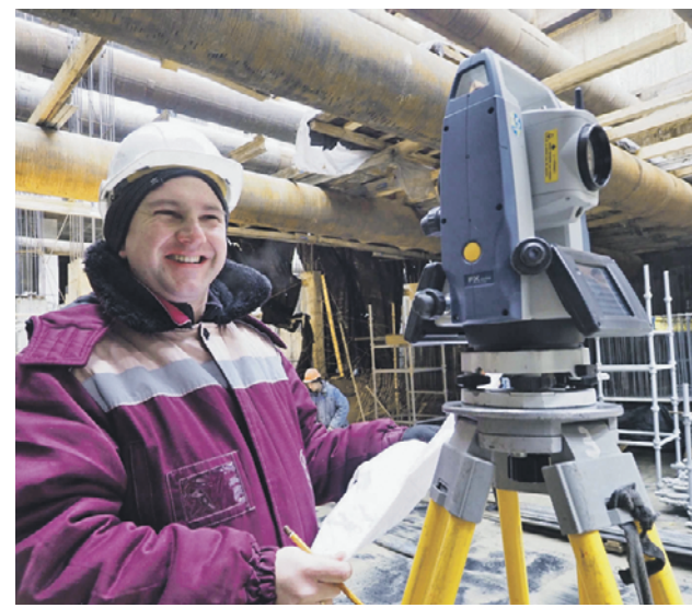
5 февраля 2019 года. Маркшейдер Денис Ловчак за работой на строящейся станции Лефортово
